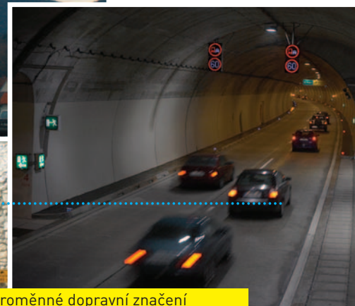
Proměnné dopravní značení do tunelů a na parkoviště
